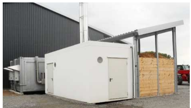
Einstock-Heizmodul 2 x 100 kW Hackgut, Gewerbe
