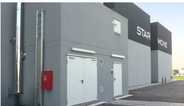
Doppelstock-Heizmodul 200 kW Hackgut, Gewerbe
