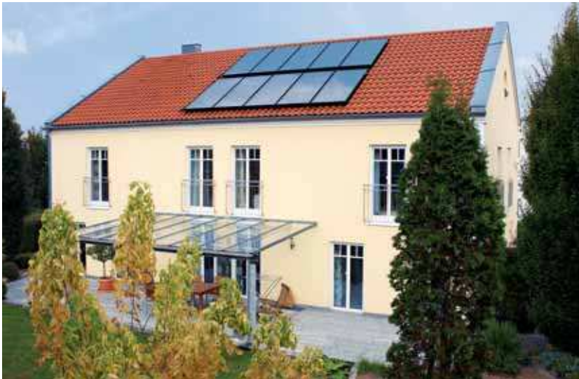
Vitosol 200-FM Zweifamilienhaus Geisenfeld
